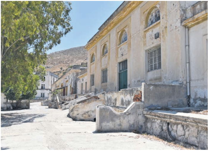
Αποψη των κτιρίων στην αεροναυτική βάση στα Λέπιδα.
