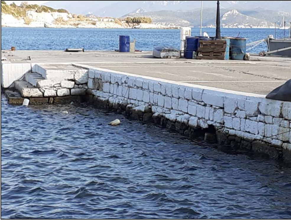
Εικόνα 6. Συνσεισμική ανύψωση 20 εκατοστών στο Πυθαγόρειο.
